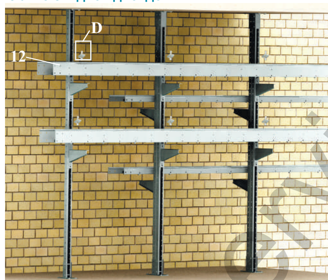
II етап – кріплення лотка драбинного до консолей
